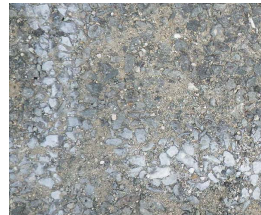
除染前の路面状況
