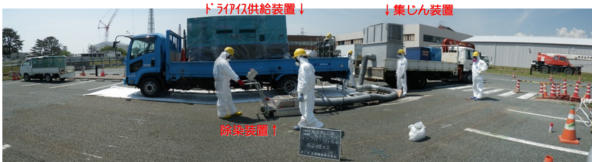
ドライアイスブラストによる除染実施状況
