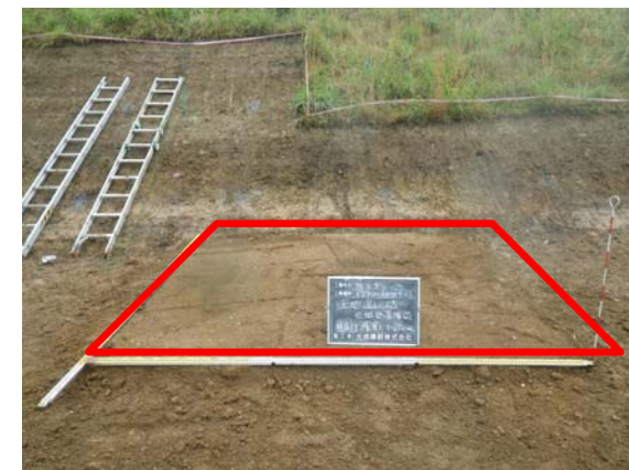
天地返し完了状況
