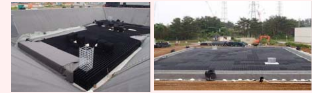
地下貯水槽設置状況
