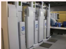
ゲートモニタ設置状況
