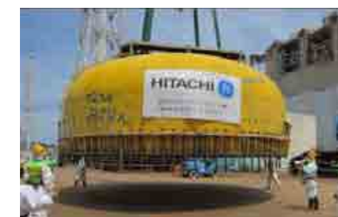
吊り降ろし作業
