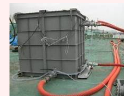
海水循環型浄化装置
