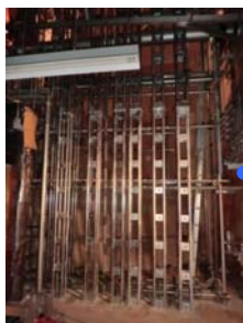
鋼製支柱（コンクリート構築前）※1
