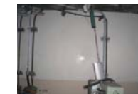
使用済燃料プールを支持する壁
