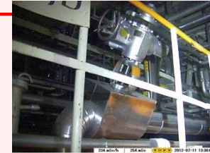
格納容器側状況
