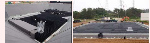
地下貯水槽設置状況
