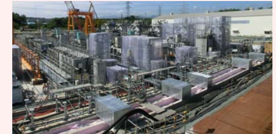
ALPS設置エリアの全景
