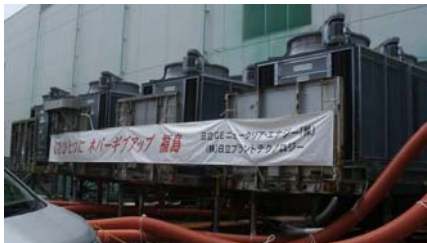
使用済燃料プール 循環冷却装置
