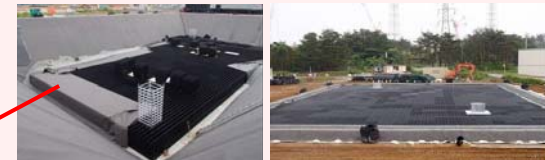
地下貯水槽設置状況
