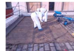
事務本館屋上コンクリート撤去
