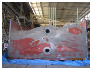
止水材注入後の積み上がり状況
