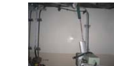
使用済燃料プールを支持する壁
