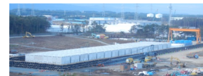
セシウム吸着塔一時保管施設 (外観)
