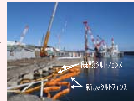
シルトフェンス交換の様子
