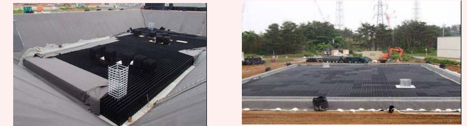
地下貯水槽設置状況
