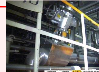
格納容器側状況
