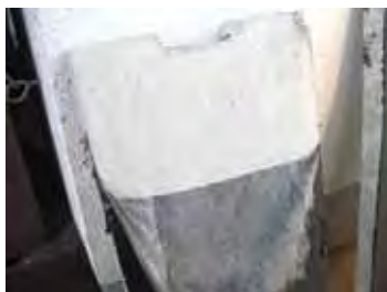
塗膜剥離状況
