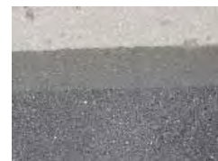
洗浄前/後 路面状況
