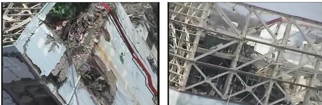
図 (ミッション①) 福島第一原子力発電所 1号機 原子炉建屋 T-Hawk からの撮影画像<sup>[4]</sup>
