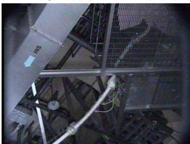
図 (ミッション③) 3号機原子炉格納容器 (PCV) ガス管理システムダクトの状況確認<sup>[6]</sup>
