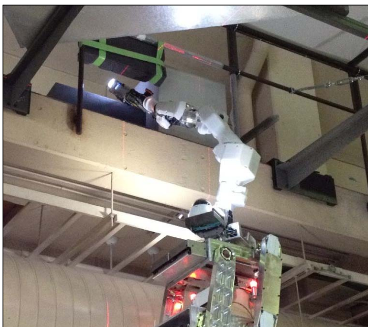
アームが高所狭隘部に進入する状況
