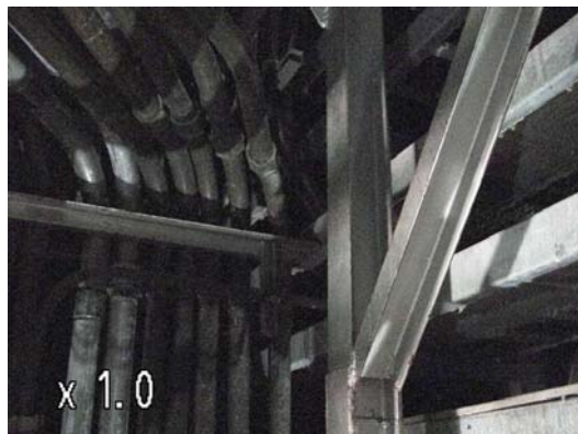
① 撮影箇所[1] P/A室上部(床上:4.4m)
