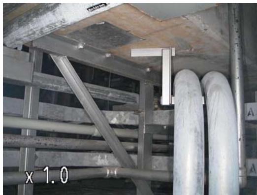
③ 撮影箇所[2] P/A室上部(床上:5.6m)
