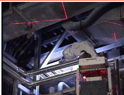
⑤ 高所調査用ロボット停止位置[1]
