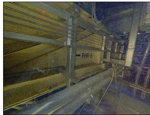
撮影箇所⑤壁面側(床上3.5m)
