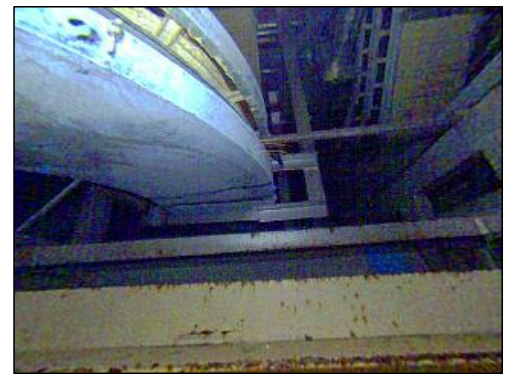
撮影箇所④壁面側上部(床上4.0m)
