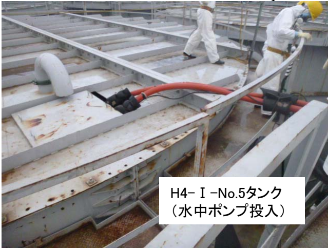
H4-I-No.5移送中の状況
