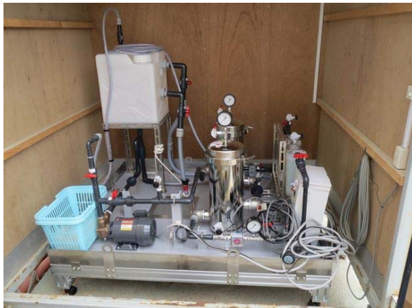
サブドレンピットでの フィルタ寿命評価試験
