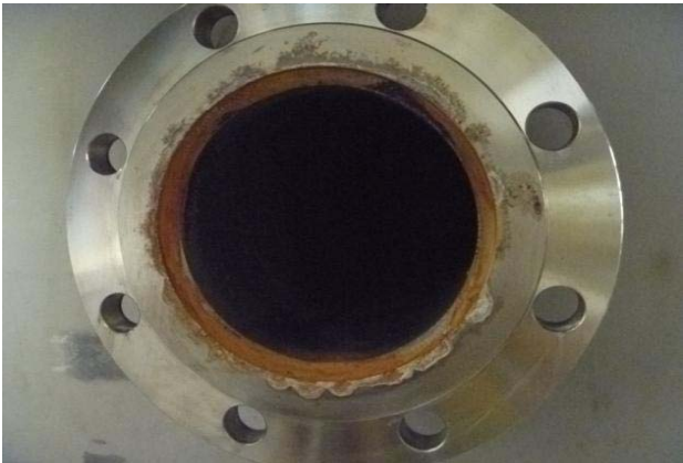
バッチ処理タンク2Aデカントノズル フランジシール面に すき間腐食有り
