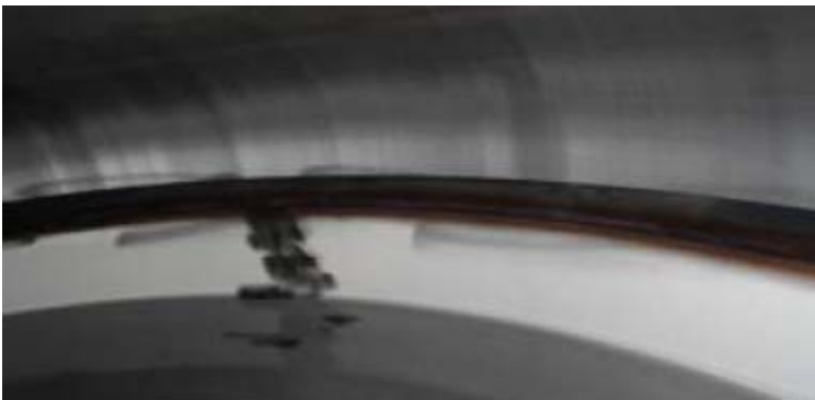
⑨吸着塔2C溶接線
