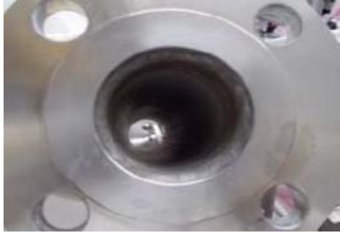
②スラリー移送ポンプ出口配管フランジ
