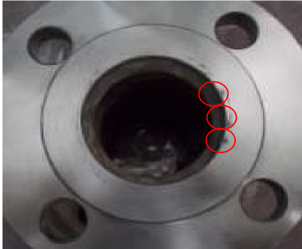
⑦供給ポンプ1出口配管フランジ
