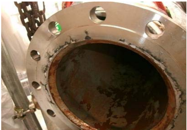
循環タンク戻り配管ノズル フランジシール面に すき間腐食有り
