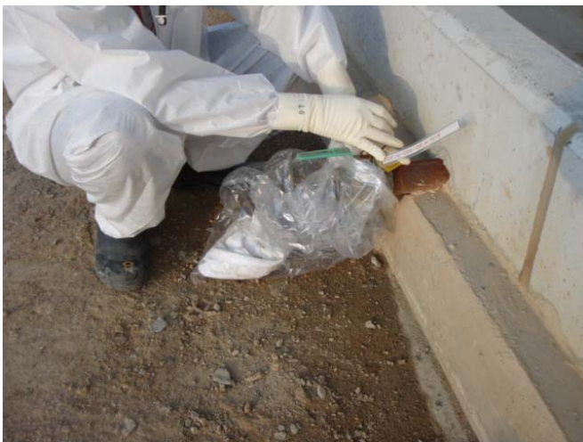
【例：堰のドレン弁】
