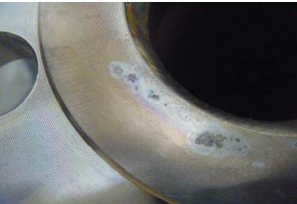
スラリー移送ポンプ出口配管(拡大) フランジシール面に すき間食有り
