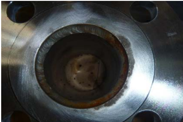
供給ポンプ1A出口配管 フランジシール面に すき間腐食有り
