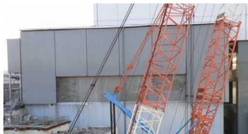
⑤ 西面（外壁）
