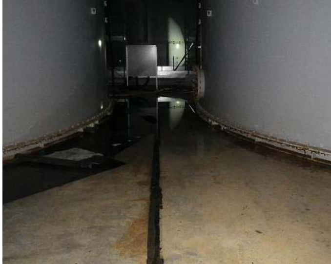
目地部のアスファルト系シール (H4東)
