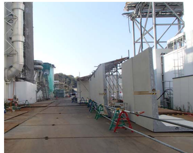
② 2号開削ダクト現況
