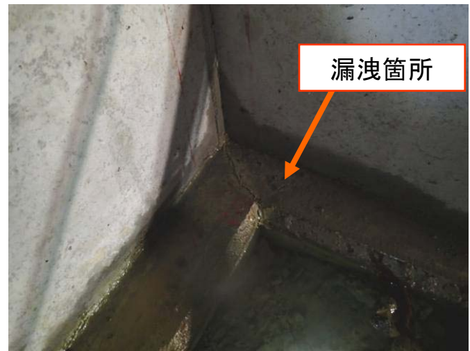
【G6北 北東角部のひび割れからの漏洩】
