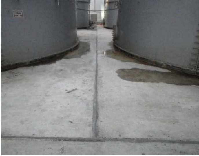
水中エポキシパテに補修 (H4東)
