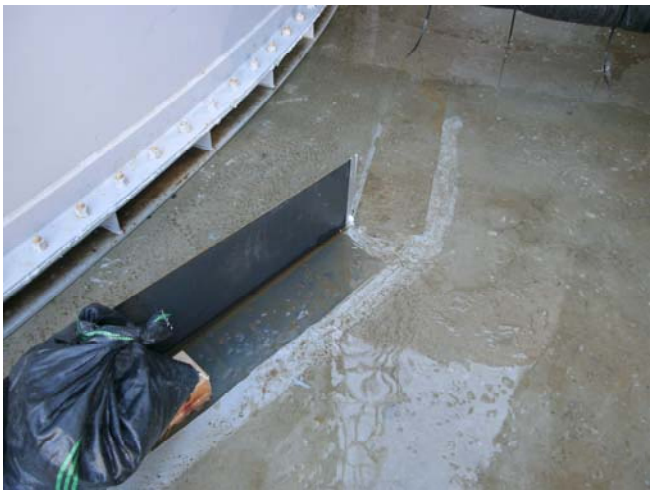
仮堰撤去の設置・撤去状況
