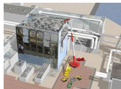
原子炉建屋上部のガレキ撤去
