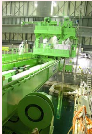
燃料取り出し状況
