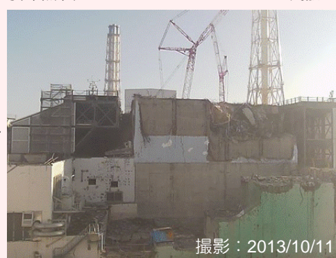
大型ガレキ撤去後
