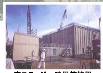
廃スラッジ一時保管施設
