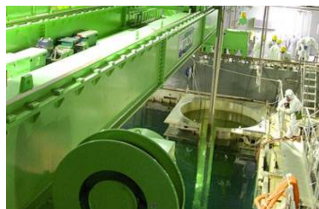
燃料取り出しの様子
