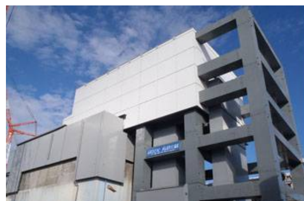
燃料取り出し用カバーの外観
