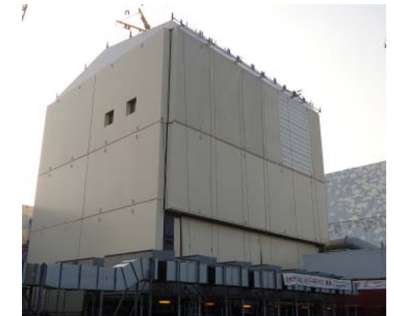
2011年10月28日カバー工事完了
