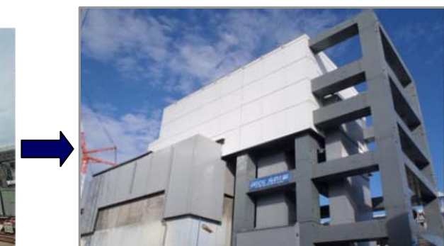
2013年11月12日カバー工事完了
