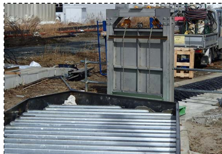
④止水ゲート施工状況（H26.2.16）
