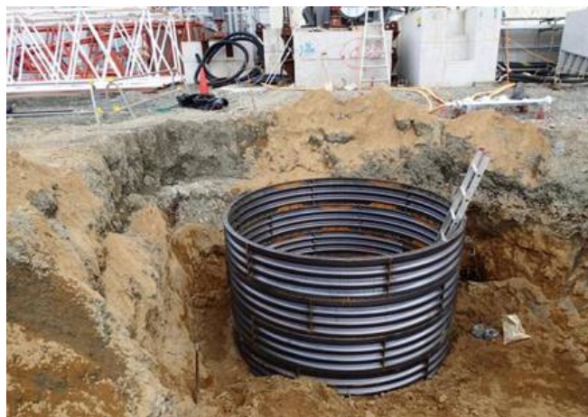
立抗掘削状況 (H26.1.9撮影)
