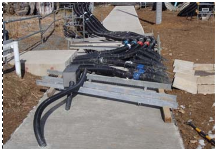
②暗渠化（コンクリート）施工完了（H26.1.22）
