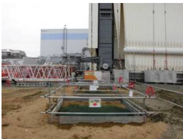
安全設備設置完了 (H26.1.15撮影)
