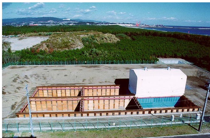
廃棄物埋設用トレンチ外観及び雨水浸入防止用テント(定置開始前)
