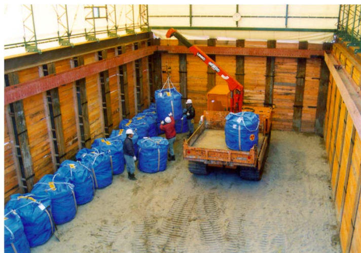
フレキシブルコンテナ封入廃棄物の定置作業状況
