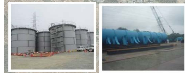
タンクの設置状況
