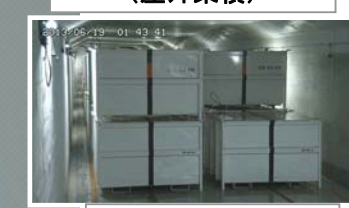
固体廃棄物貯蔵庫
