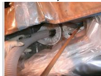
鉛マット 砂礫回収用フィルター
