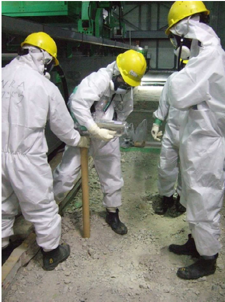
A: 建屋床面露出部
