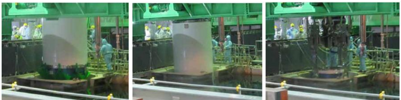
プールへの着水作業状況 (H25.11.18)
