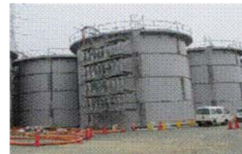
フランジタンク
