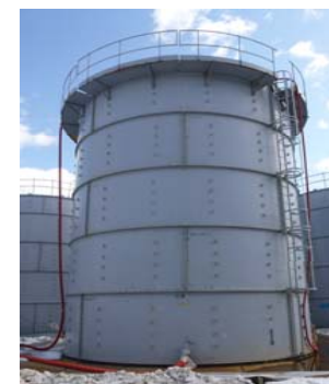
500m 3 フランジタンク
