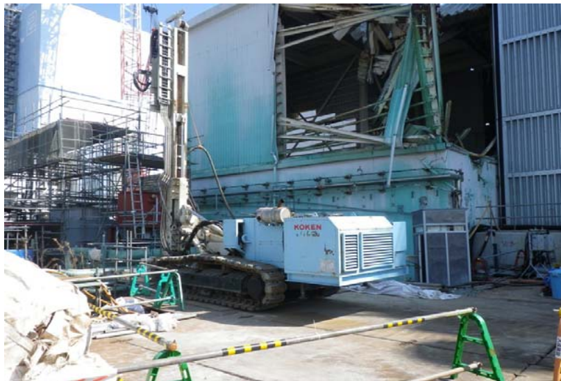
新設サブドレンピットN9（掘削状況）
