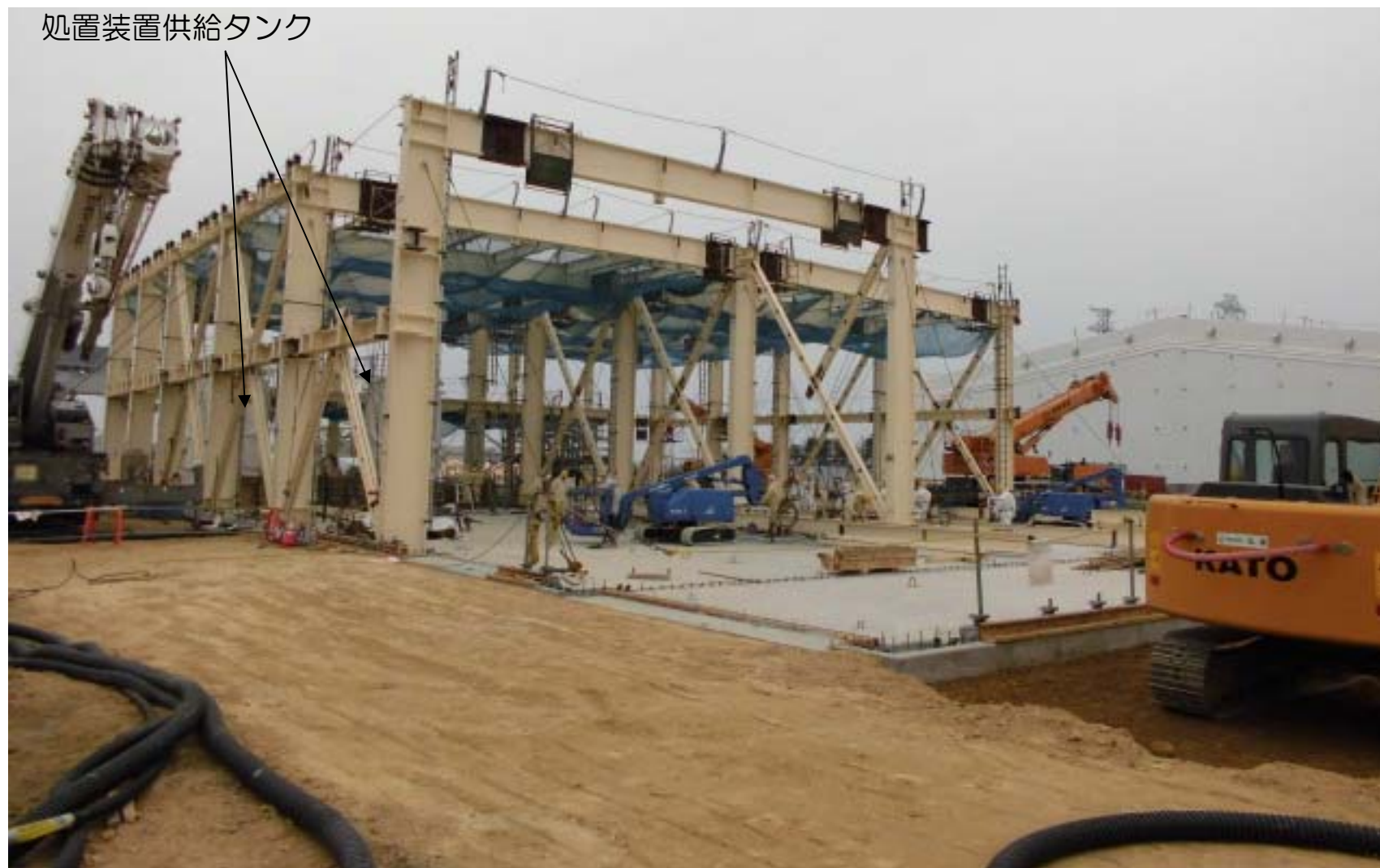
鉄骨建方状況
