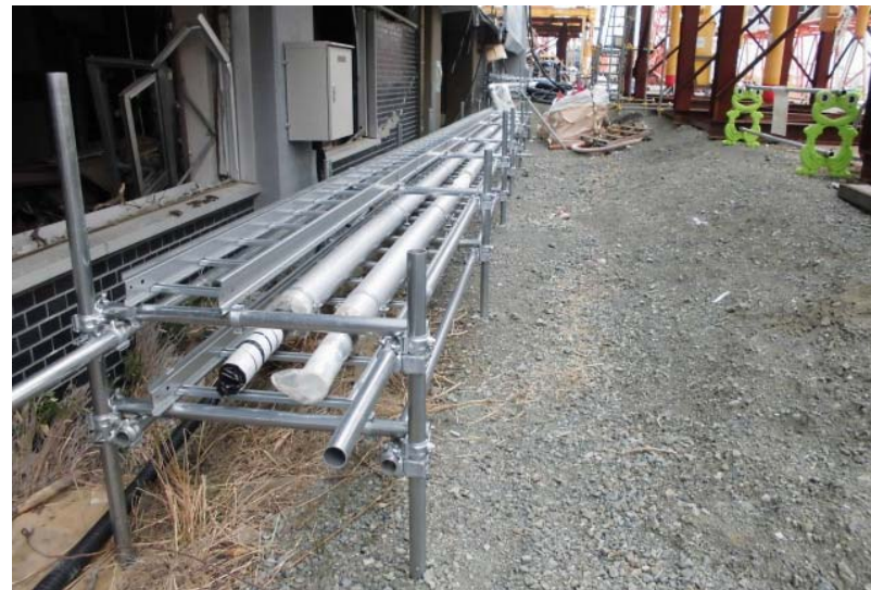
水移送配管敷設状況
