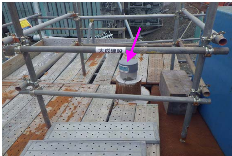
新設サブドレンピットN3（掘削完了）
