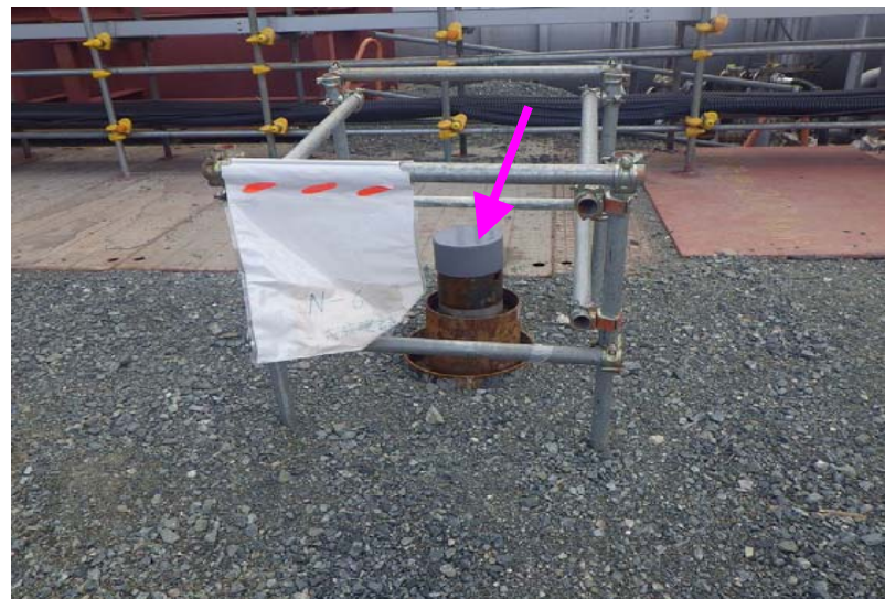
新設サブドレンピットN6（掘削完了）
