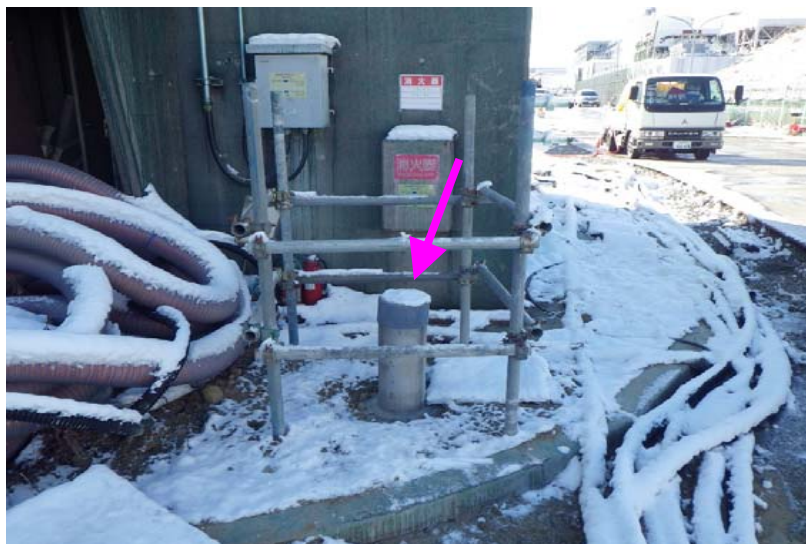
新設サブドレンピットN7（掘削完了）
