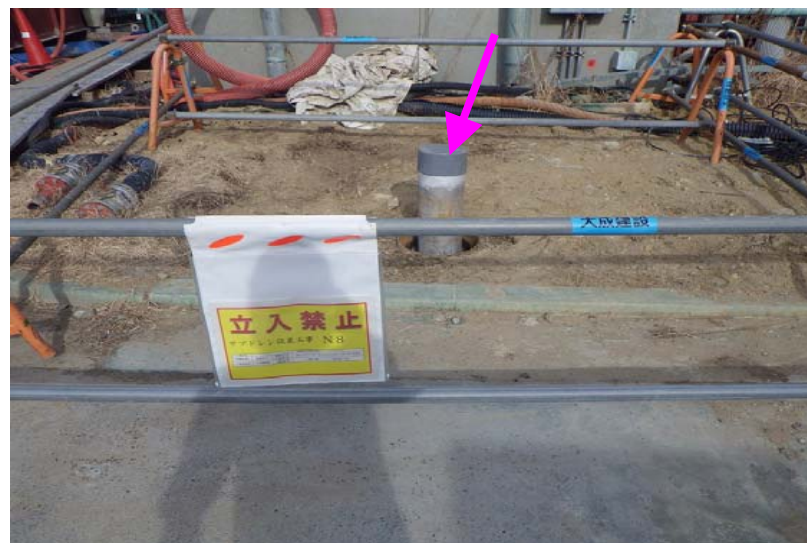
新設サブドレンピットN8（掘削完了）
