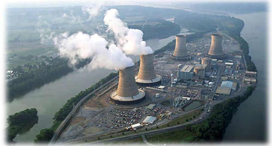
スリーマイル島原子力発電所
