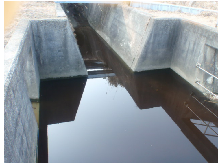
A排水路開渠部（清掃後）
