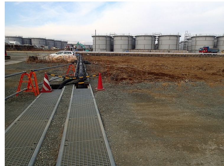
地下水バイパスエリア伐採状況
