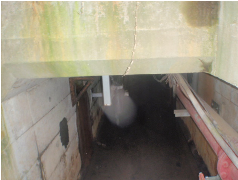
K排水路暗渠部
