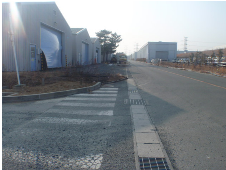
事務本館前道路・側溝
