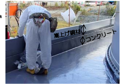
鋼製板による堰の嵩上げ実施状況
