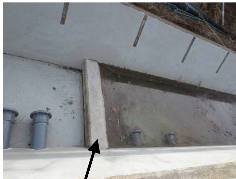
排水路汚泥堰 (例)
