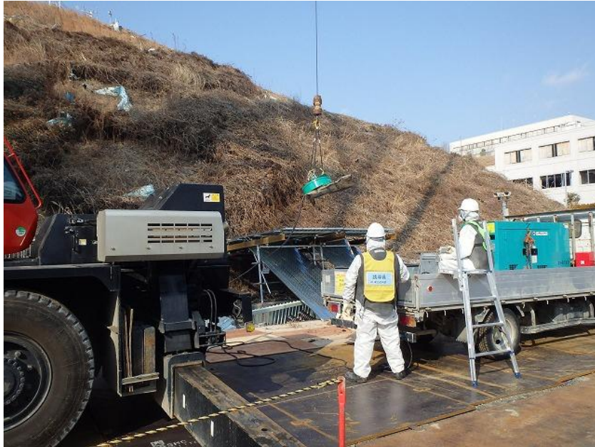
凍土方式遮水壁大規模実証事業 (1号機R/B 西側) 1号外壁ガレキ撤去 (マグネットリフタ使用)
