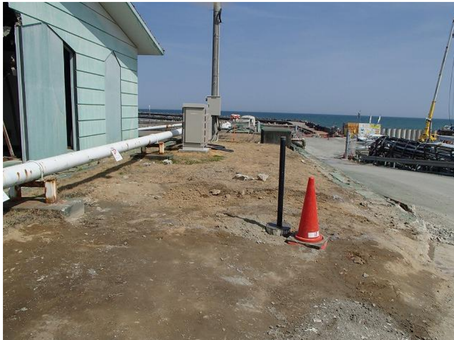
凍土方式遮水壁大規模実証事業 (4号機T/B 東側) 土質調査ボーリング (Fz-8) 削孔、観測孔設置完了
