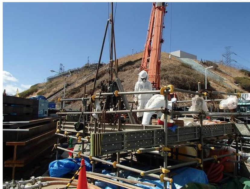
凍土方式遮水壁大規模実証事業 (1号機R/B 北西側) 土質調査ボーリング (Fz-2)
