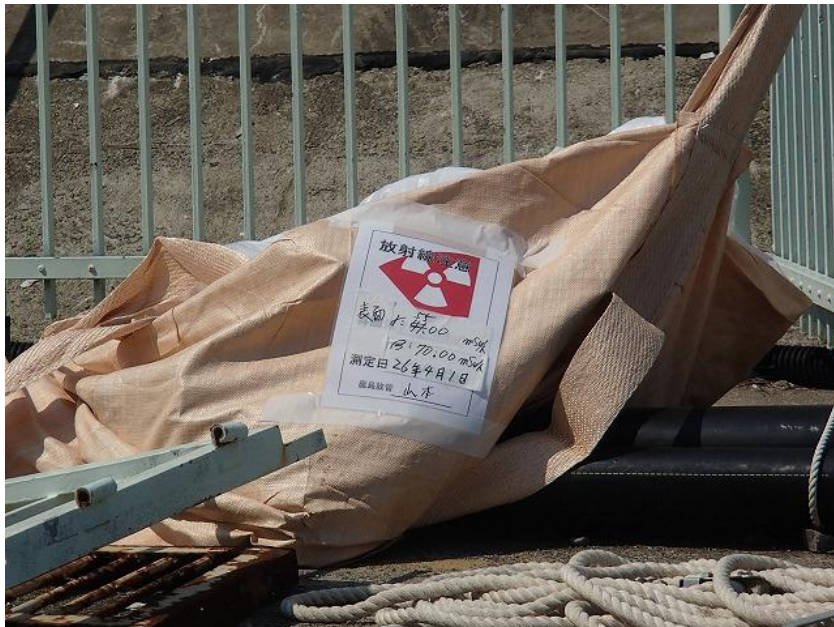
凍土方式遮水壁大規模実証事業 (1号機R/B 西側) ガレキ撤去 (高線量ガレキ)
