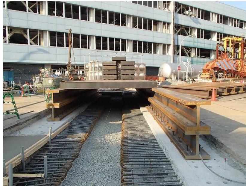
凍土方式遮水壁大規模実証事業 (1号機R/B 北西側) 4BLKトレンチ構築
