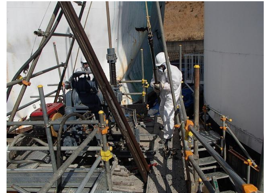
凍土方式遮水壁大規模実証事業 (1号機T/B 北側) 土質調査ボーリング (Fz-3)
