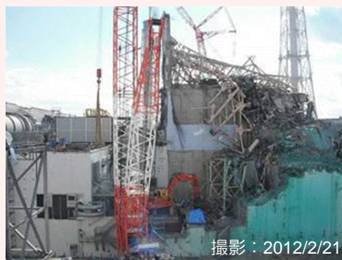
大型ガレキ撤去前
