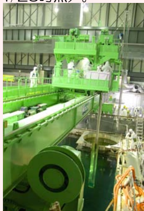
燃料取り出し状況
