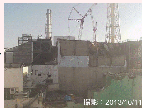
大型ガレキ撤去後
