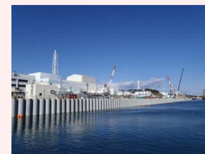
海側遮水壁工事状況
