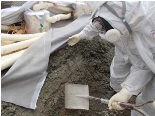
写真 凍結状況(上図、赤枠部分)
