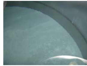
吸着塔 4 A 吸着材 2 が白色であり、白 い堆積物の目視確認は困難
