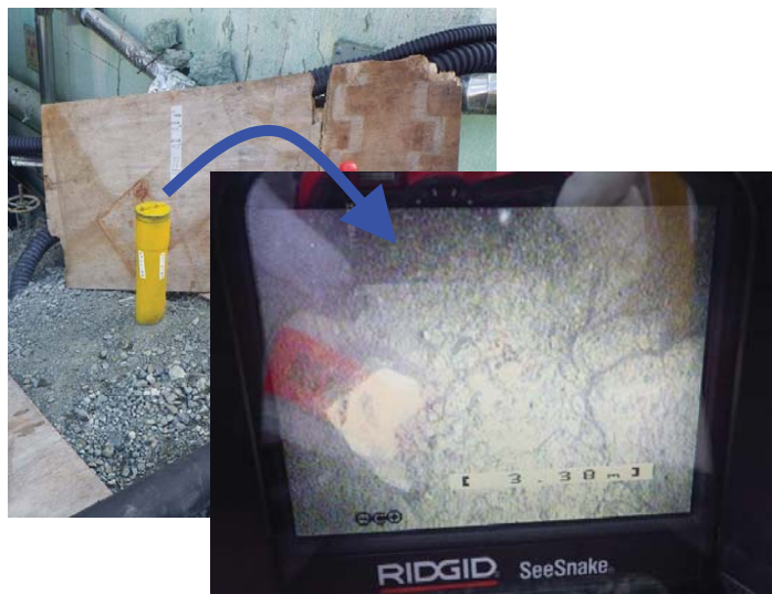
No.48ピット内部
