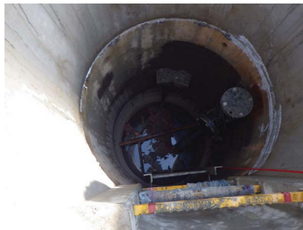
No.51ピット内部
