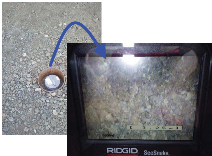
No.49ピット内部
