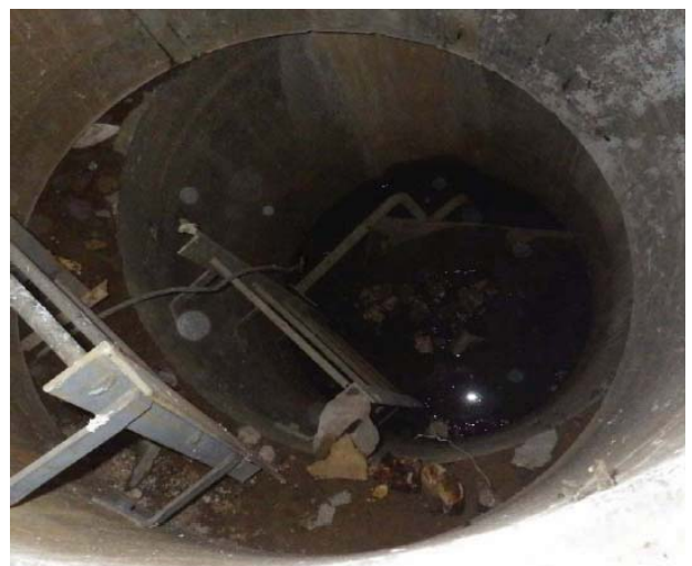
No.41ピット内部
