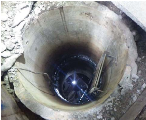
No.40ピット内部
