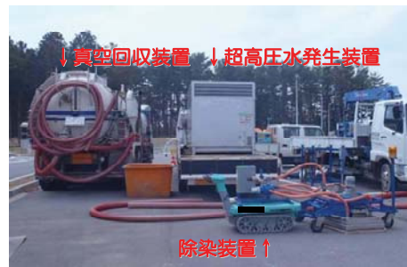
超高压水切削システム全景
