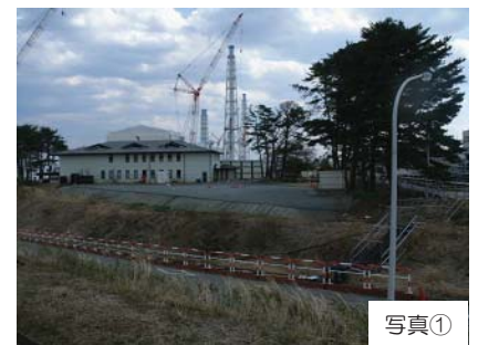
伐採、表土除去後の状況
