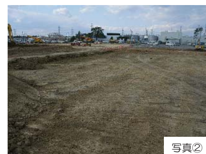
伐採、表土除去後の状況
