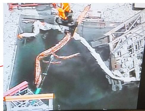
屋根トラス撤去(H26.3.28)
