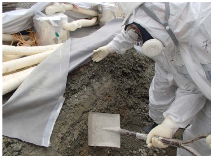
写真 凍結状況(上図、赤枠部分)
