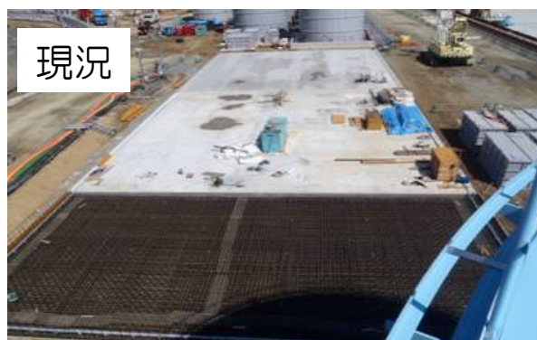
【G7エリアタンク基礎設置状況】
