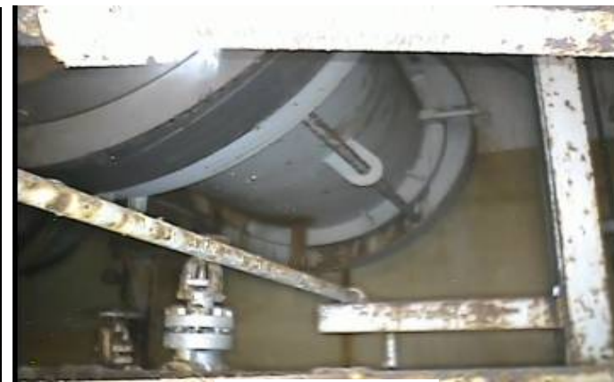
主蒸気配管C
