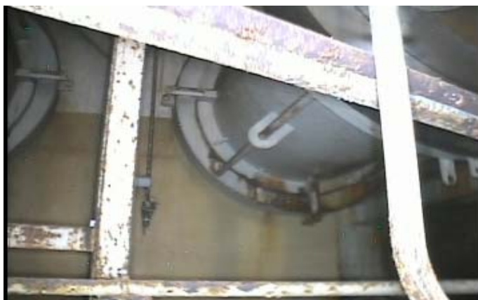
主蒸気配管B
