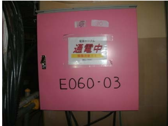
仮設分電盤N-1 (プロセス主建屋2階)
