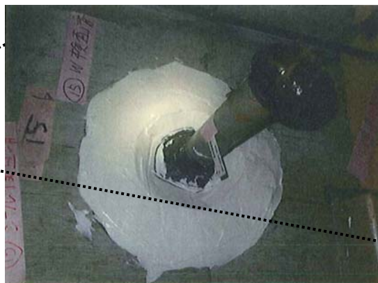
焼却-工作建屋間配管貫通部止水状況
