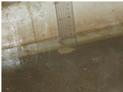
工作建屋における止水処置実施後の残水状況 （平成23年6月9日撮影）
