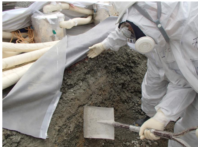
写真 凍結状況(上図、赤枠部分)
