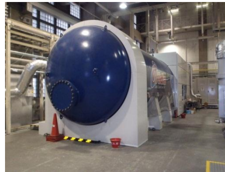
実証機 東京ガス(株)千住サイト
