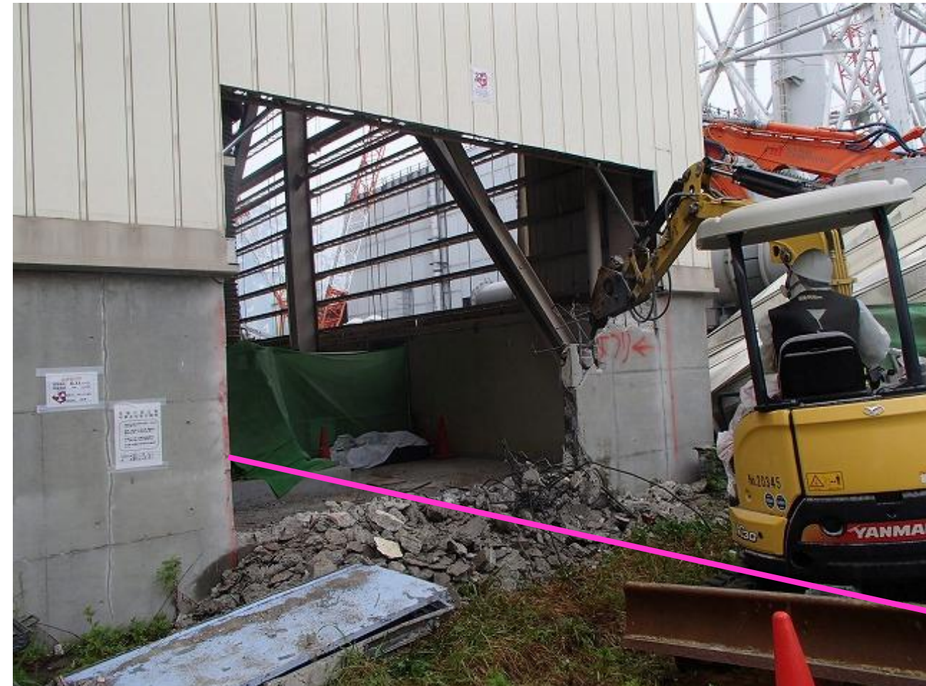
写真⑤ 高圧開閉所壁撤去
