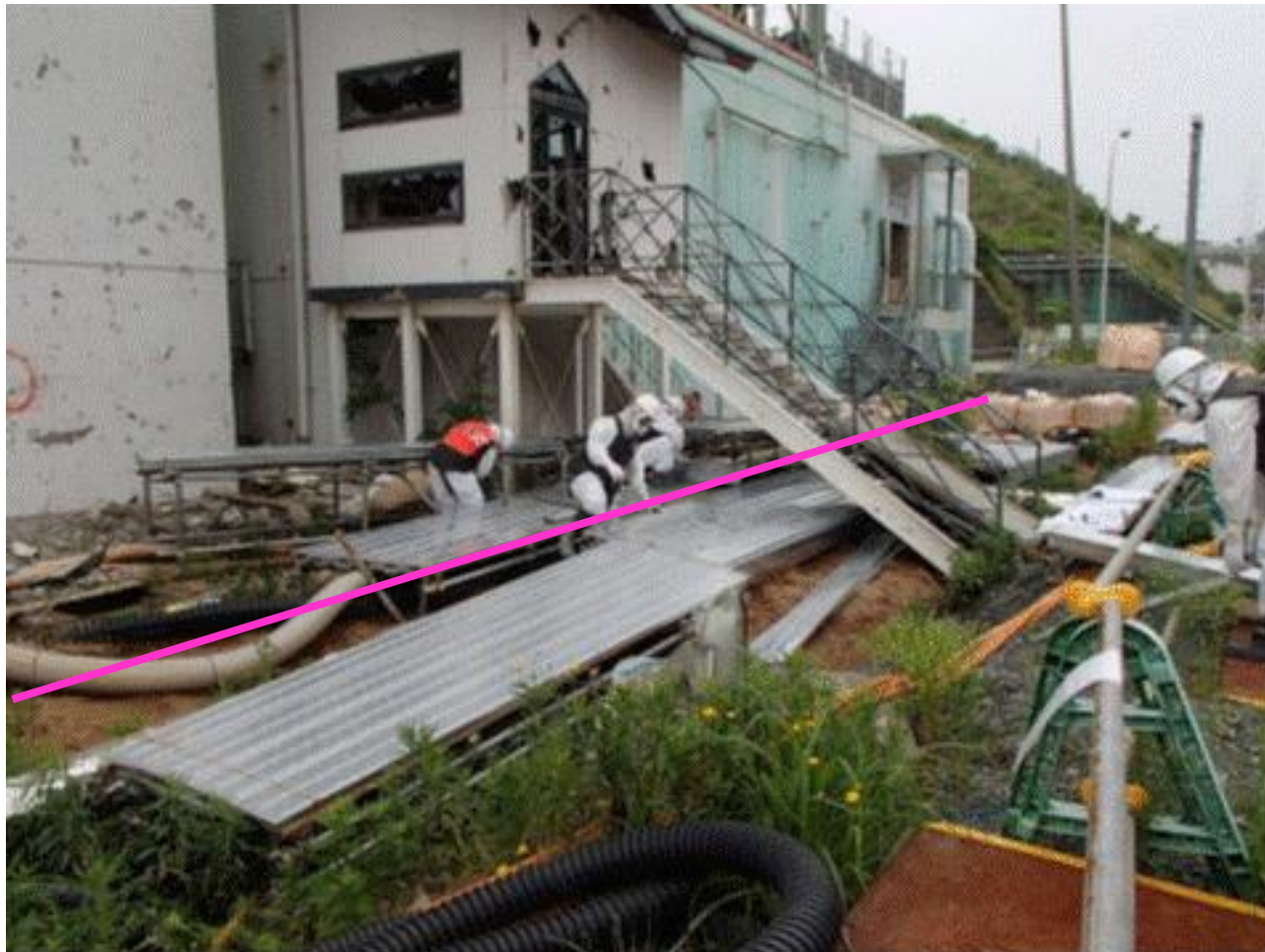
写真④ ホールドアップ 建屋配管防護
