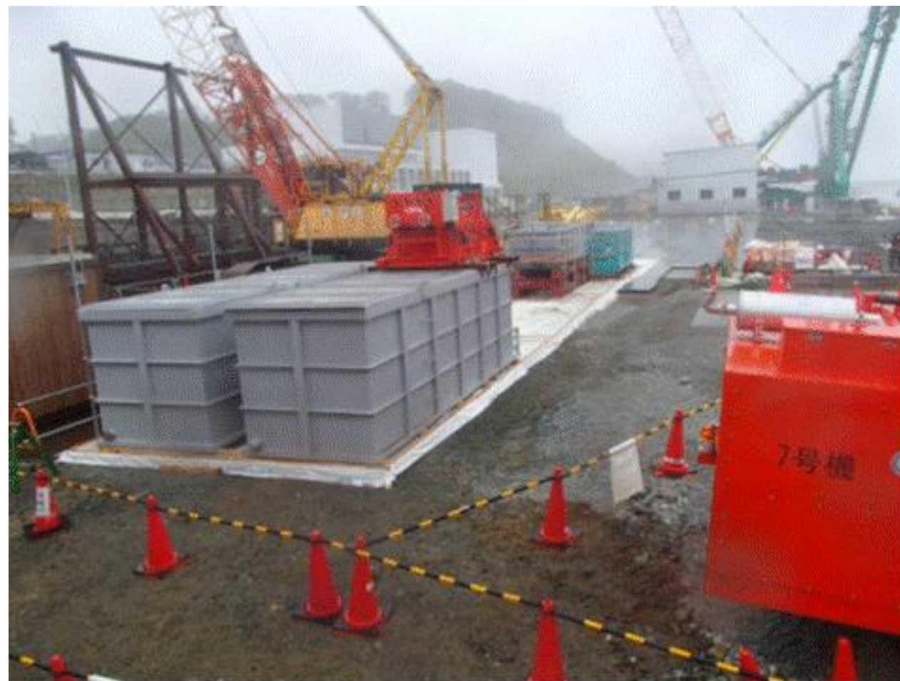
写真① 1BLK削孔プラント設置状況
