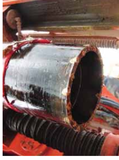
ケーシング先端部 (ビット配置；外ビット)
