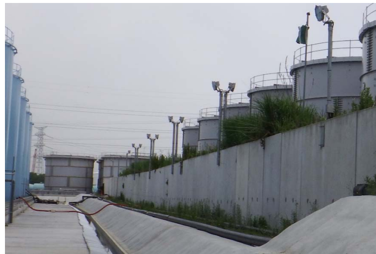
写真③ H8・Eタンクエリア内側照明設置状況
