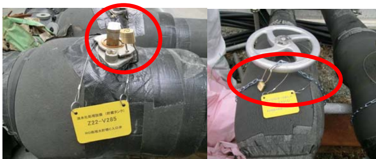
写真② 弁施錠管理
