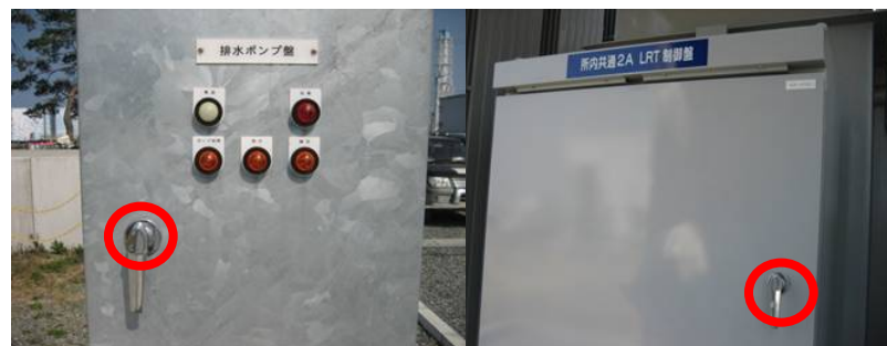
写真④ 電源盤施錠管理
