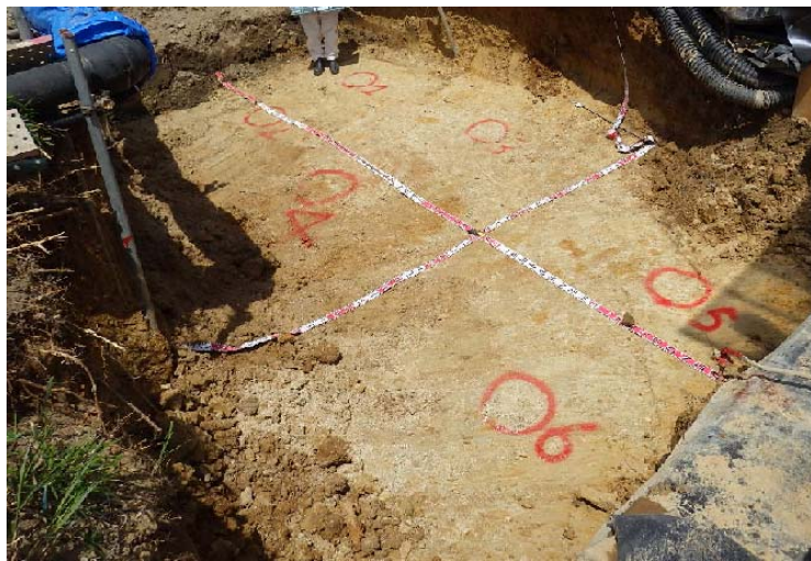
写真① H6周辺土壌回収状況
