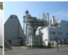
木質バイオマス発電 (白河市)
