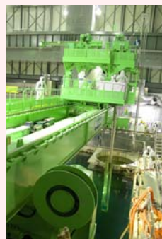
燃料取り出し状況
