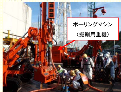
<陸側遮水壁 凍結管設置工事状況>
