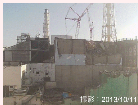
大型ガレキ撤去後
