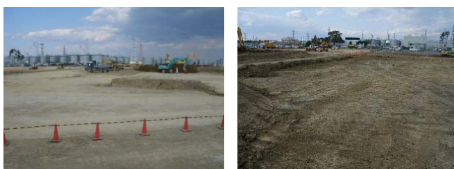
<伐採、表土除去後の状況>
