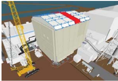
①屋根パネル解体開始
