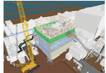
⑥建屋カバー解体完了
