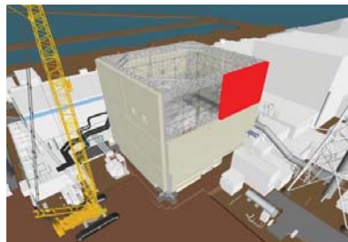
②壁パネル解体開始
