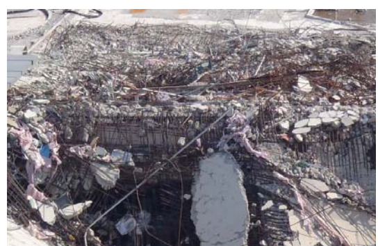
G工区（北西崩落部）拡大写真
