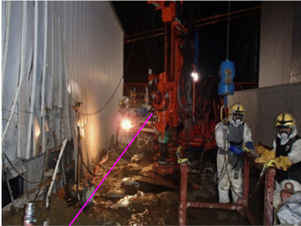
写真②-2 3BLK削孔中 (1セツト)
