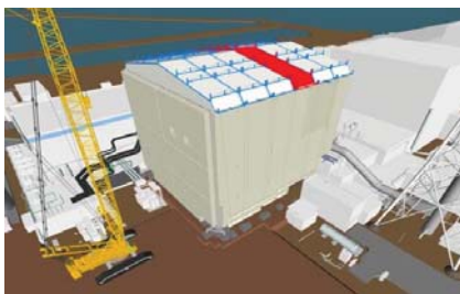
①屋根パネル解体開始
