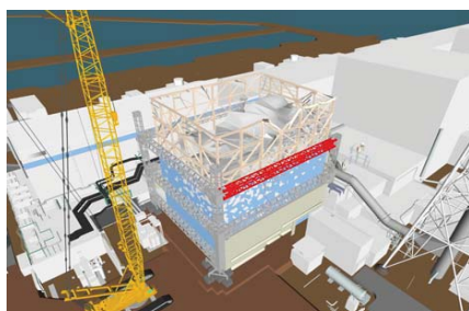
④梁取り外し※
