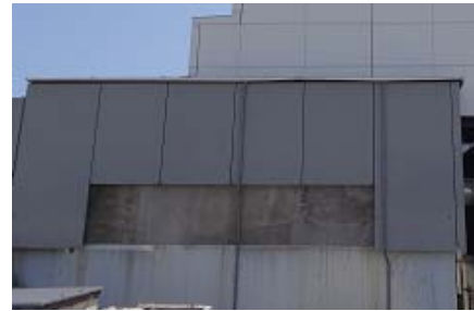
⑤ 西面（外壁）
