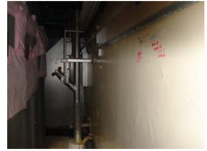
④ 西面（内壁）
